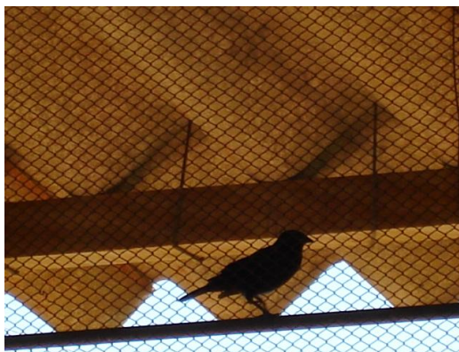
Foto 5 – Detalhe da presença de pássaros próximos ao aviário
