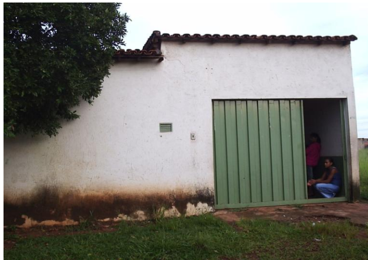
FIGURA 3: UBSF Shopping Park: fachada externa, 2007. FOTO: Rodrigues, M. J. 2007.
