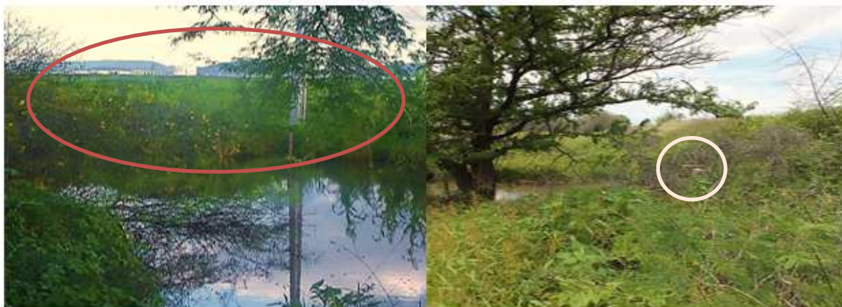
Figura 1: Escoamento da água de um lado para o outro da rodovia
