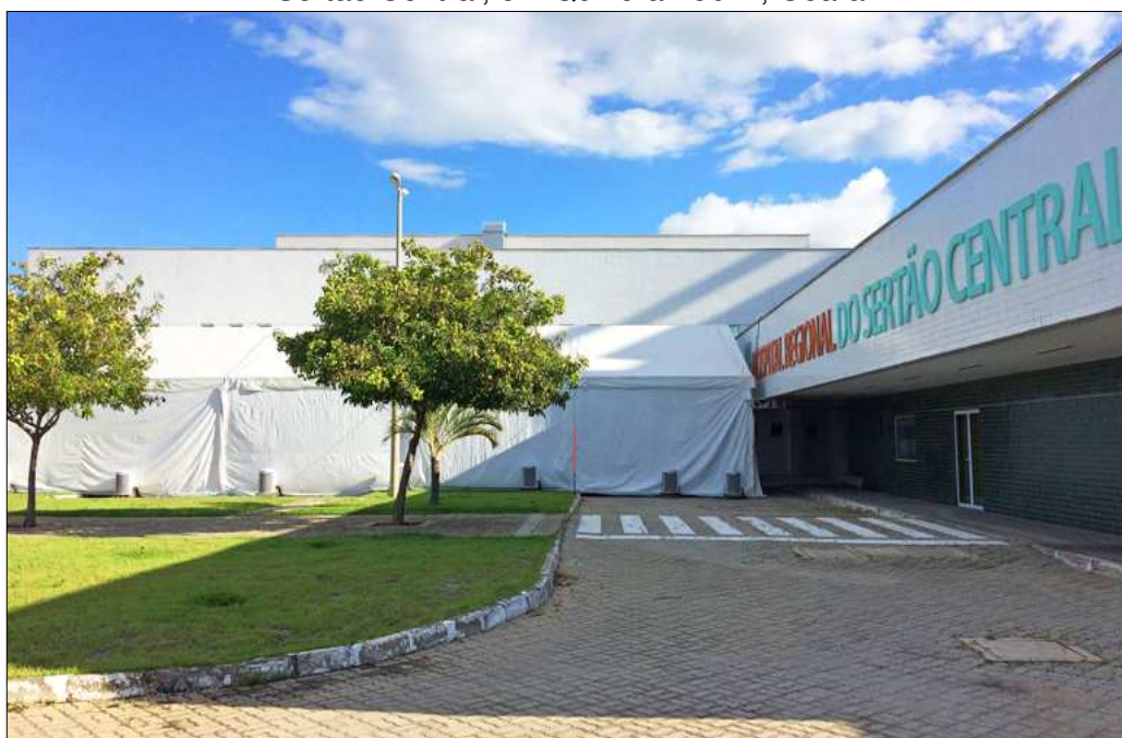
Figura 8: Hospital de campanha construído em estrutura anexa ao Hospital Regional do Sertão Central, em Quixeramobim, Ceará
